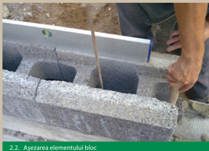
2.1. Așezarea elementului bloc
