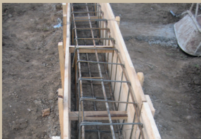
1.1 Executare fundație continuă
