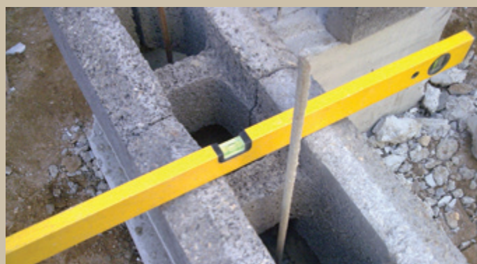
2.1. Așezarea elementului bloc
