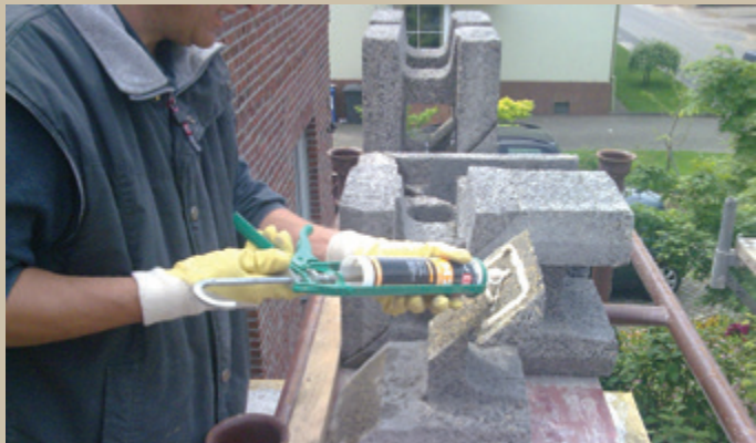
3.2. Fixarea elementului de colț cu spumă adeziv universală Leier FIX
