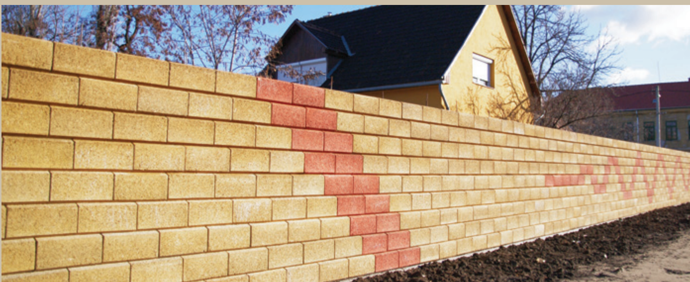
Sistemul de perete pentru atenuarea zgomotului, finalizat
