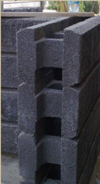
4.4. Capăt de zid înainte de cofrare
