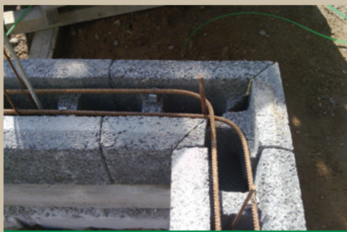
4.1. Montarea armăturii la colțuri
